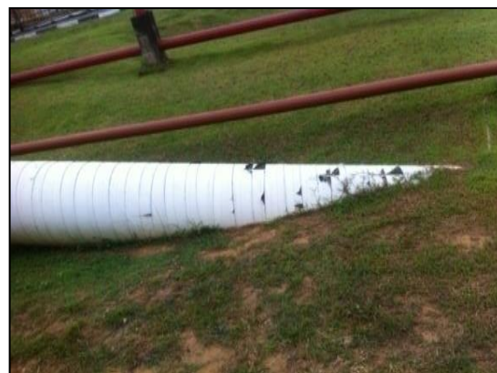
Gambar 2.19 Pelapisan ( Wrapping )
