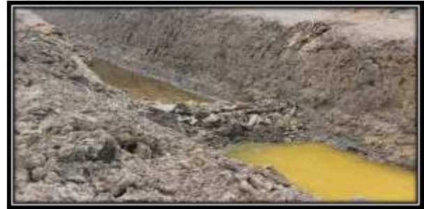
Gambar 4.5 Kondisi Saluran Tambang longsor
