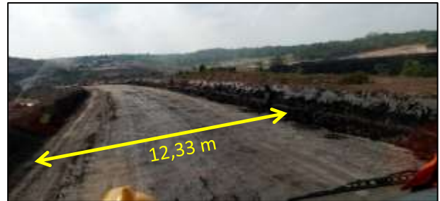
Gambar 4.2 Lebar Jalan Angkut Lajur Lurus pada Segmen F-G
