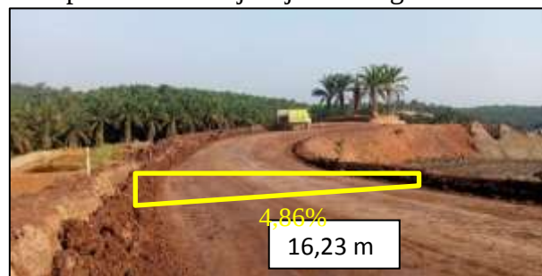
Gambar 4.8 Superelevasi Aktual Jalan Angkut Overburden
